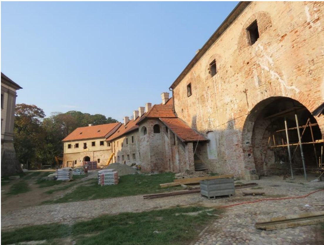
Slika 12. Zgrade prostora muzeja Riznica Međimurja tijekom renovacije
