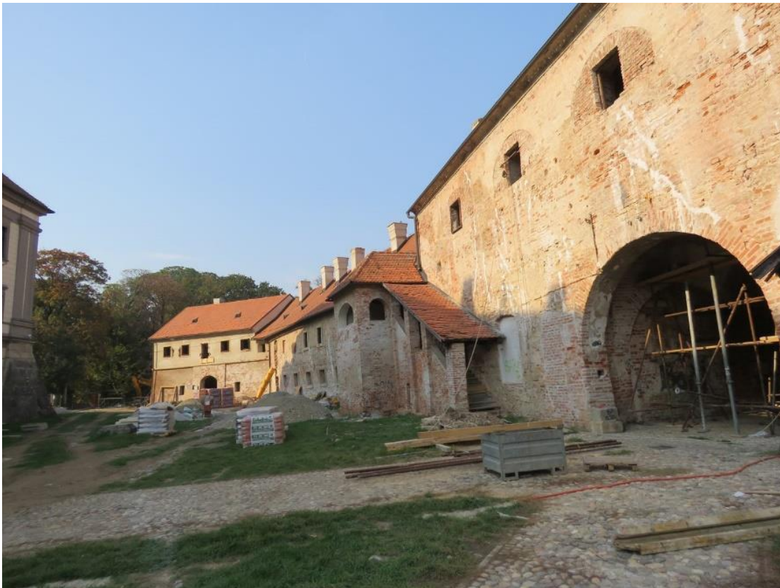
Slika 12. Zgrade prostora muzeja Riznica Međimurja tijekom renovacije
