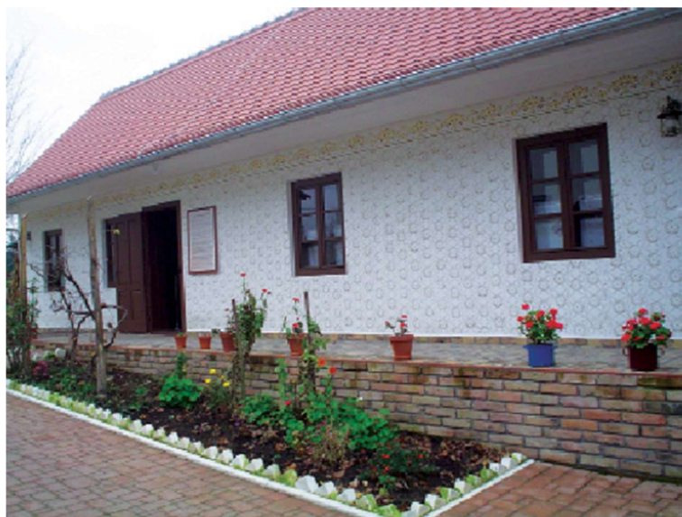
Slika 11. Rodna kuća Ivana Kozarca nakon obnove ( https://www.ivankozarac.com/rodna-kuca , 20. srpnja 2024.)
