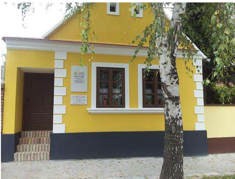
Slika 12. Rodna kuća Ivana Kozarca nakon obnove ( https://www.matica.hr/vijenac/537/blistava-obnova-kozarceve-kuce-23679/ , 20. srpnja 2024.)
