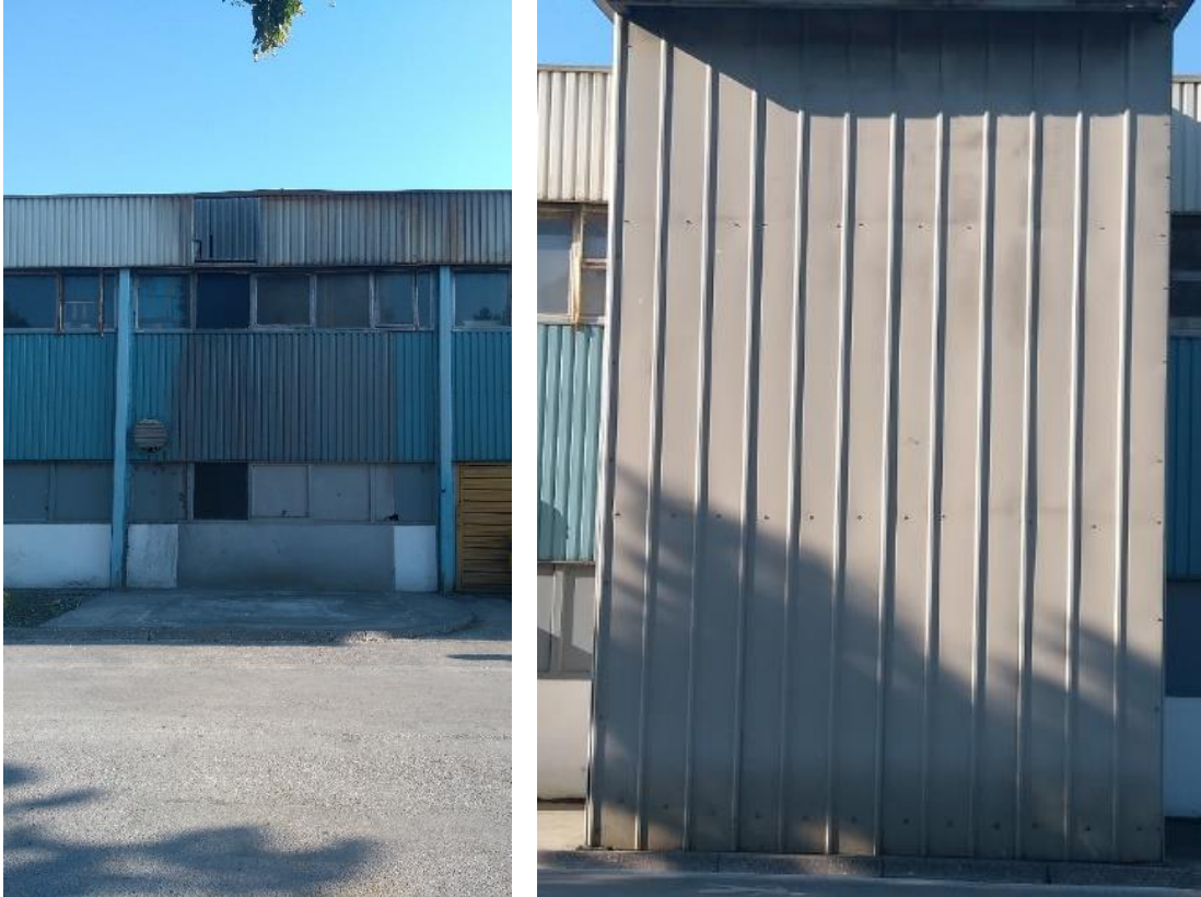
Slika 19. Ugrađena protuzvučna panel pregrada obloženog panelom za smanjenje buke
