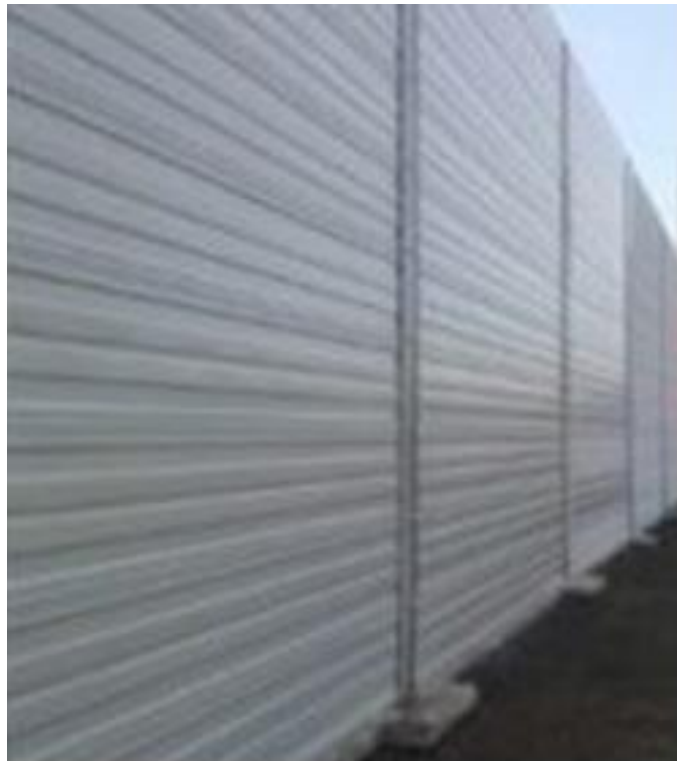
Slika 19. Ugrađena protuzvučna panel pregrada obloženog panelom za smanjenje buke
