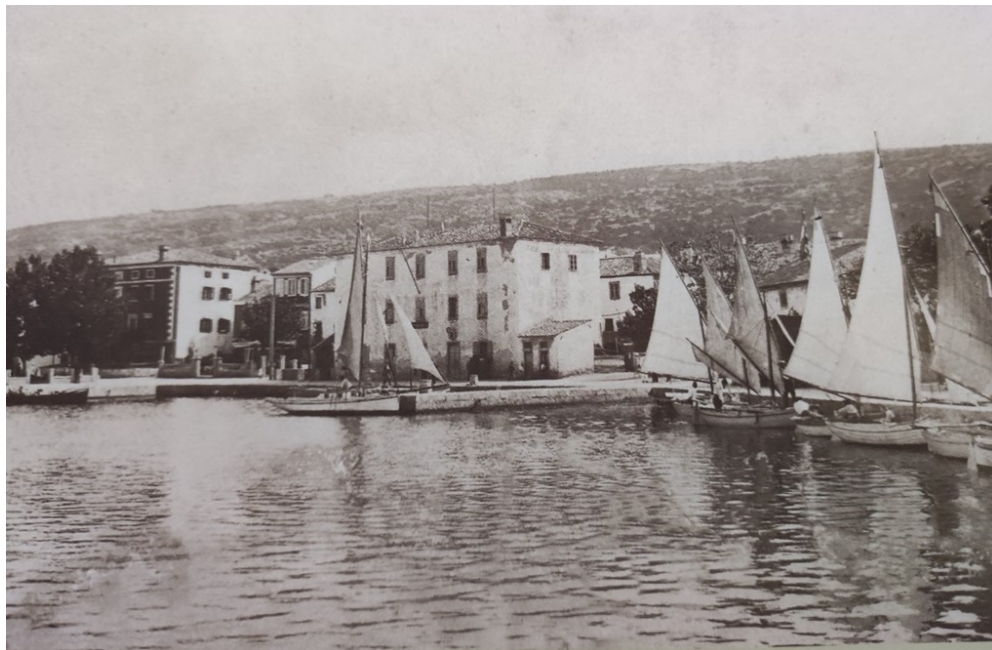
Primjer 4. Zgrada Pučke škole u Puntu
