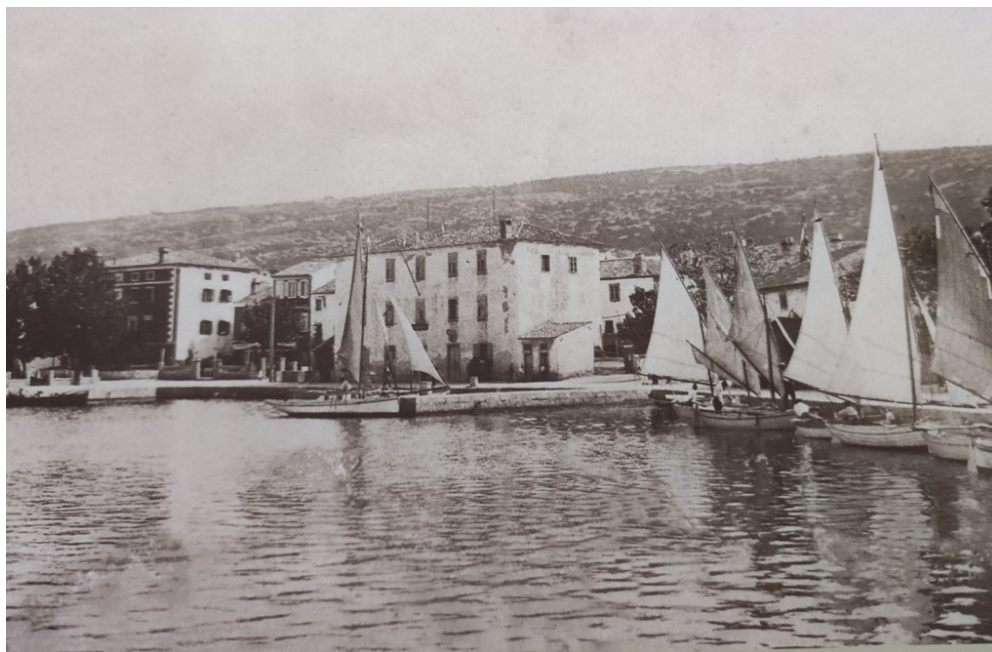
Primjer 4. Zgrada Pučke škole u Puntu
