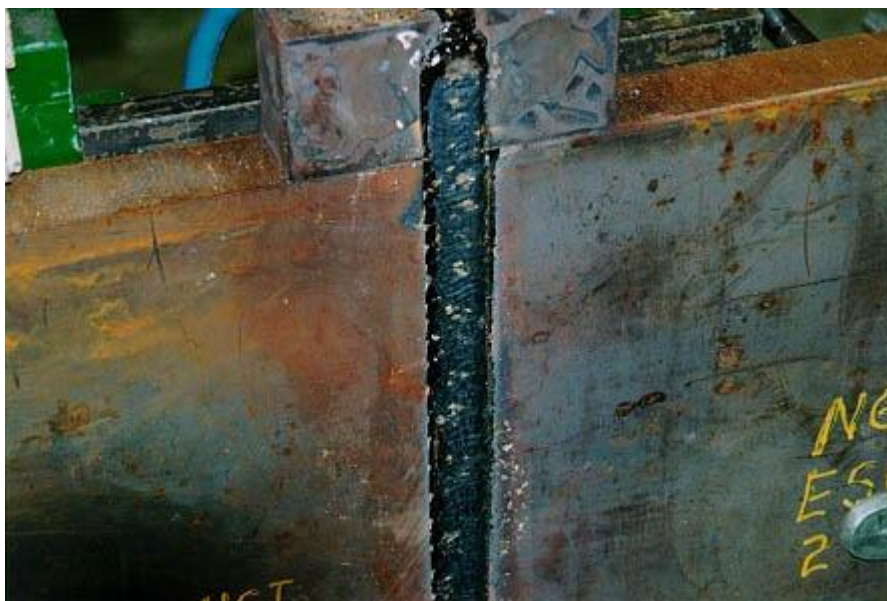
Sl.9 slika zavarenog spoja dvaju debljih čeličnih ploča putem ESW tehnologije, izvor: https://www.totalmateria.com/en-us/articles/electro-slag-welding-esw-of-steels-1/ (14.9.2024)
