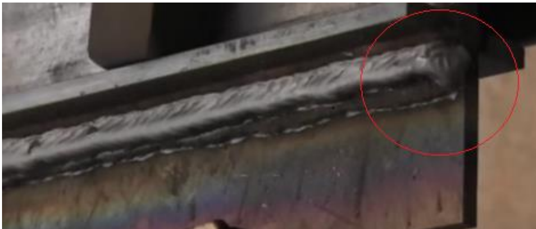
Sl.19 Slika početka trećeg nanosa zavarivanja dok se jos nije ohladio zavareni spoj kako treba, staložilo se na početku i krene se topit, izvor: https://www.youtube.com/watch?v=uvjZNTqi_aU&t=2s (17.9.2024)
