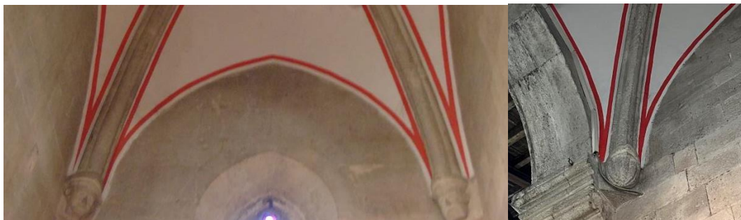
Slika 13. Crkva sv. Franje - konzole rebara svoda
